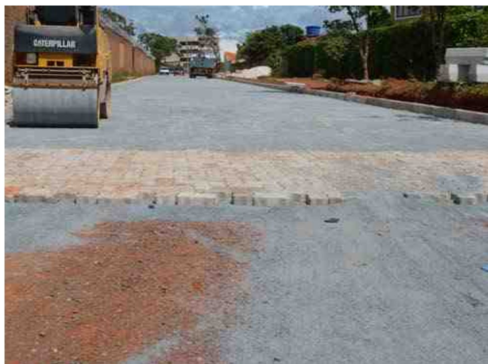
Obras da Perimetral Centauros – futura Rua do Lazer
